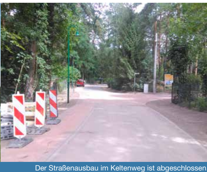
Der Straßenausbau im Keltenweg ist abgeschlossen.
