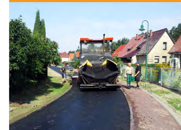
Die Straßenbauarbeiten in der Fliegersiedlung gehen voran.
